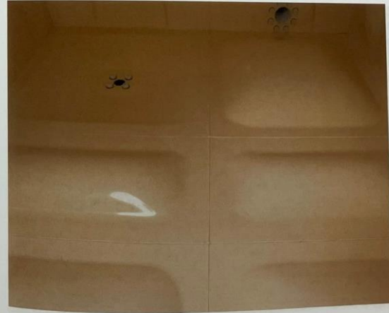
令和 6年 5月 21日 測点 高架水槽No.1 槽底部 工事概要 飲料水貯水槽清掃
